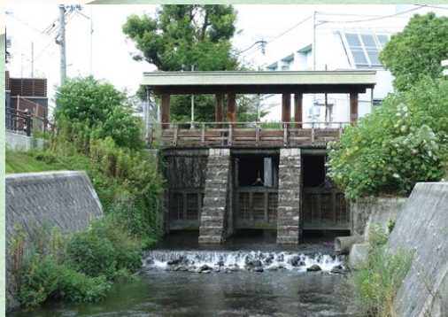
黒川樋門 / 昔、黒川に流す水量を調節するのに使われていたゲート。三階橋東南(北区辻町)にある。
