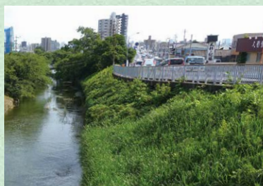
水分橋南の県道102号と水路
