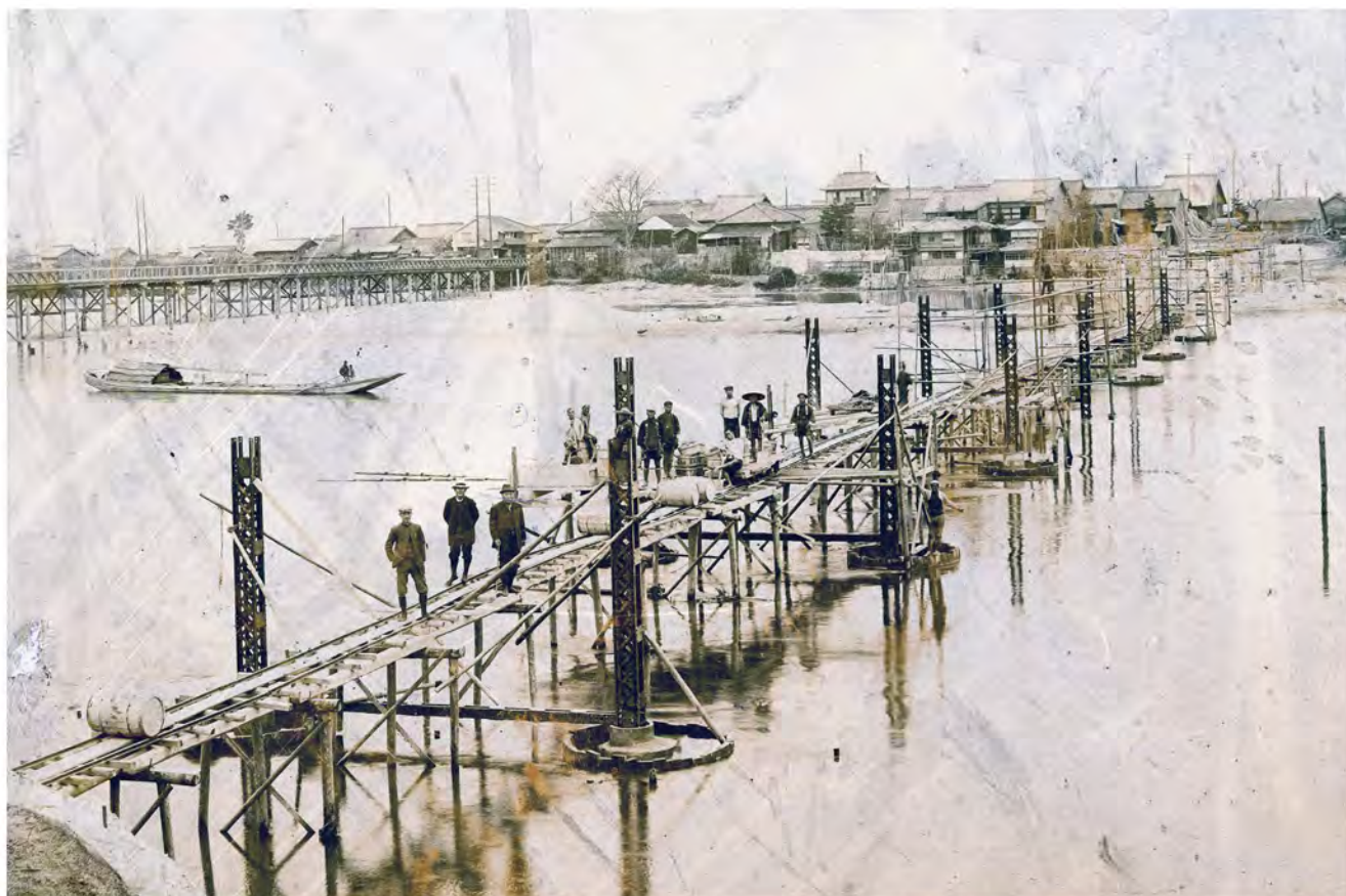
工事中の矢作橋 大正2年頃
