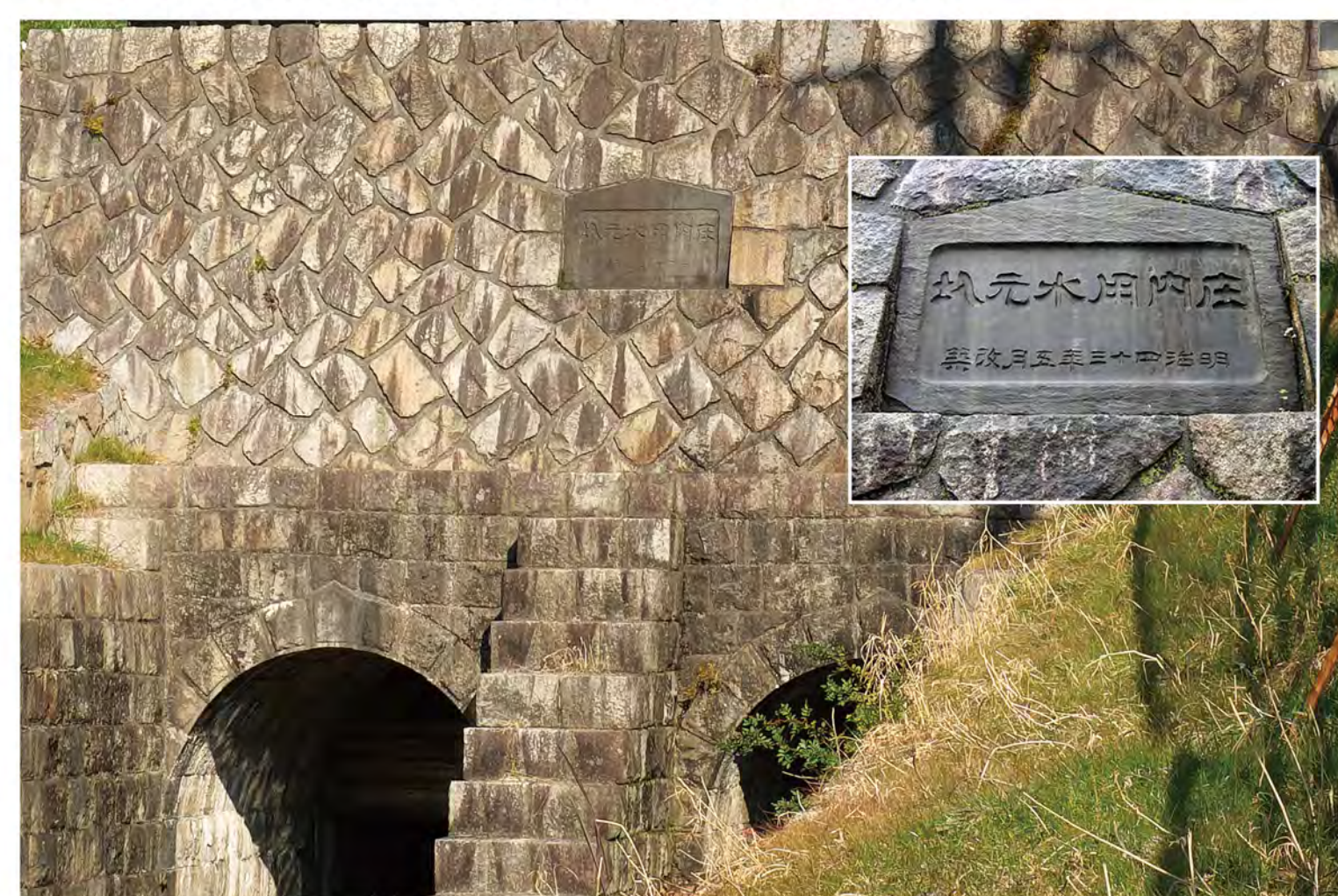
▼人造石で改築時の銘板（右に拡大）が取り付けられている庄内用水元杵樋門の胸壁部分（堀川側）
